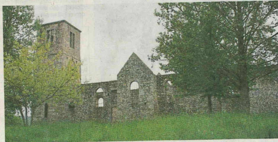
Même en ruine, l'église est encore entretenue.
